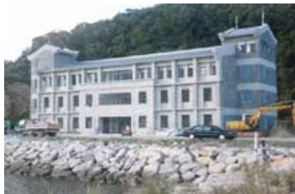
2013 年完工之北巡局山隴安檢所廳舍外觀
