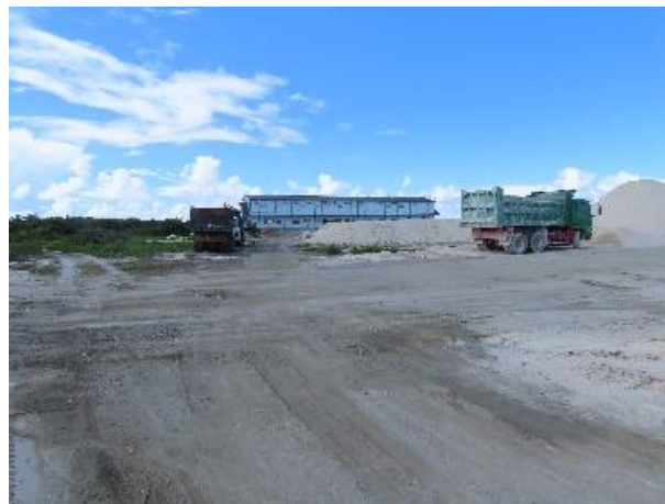
施工便道及工務所
